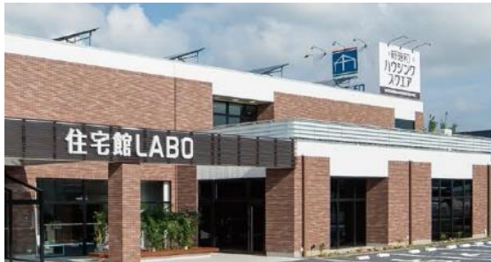
住宅館 LABO 外観
